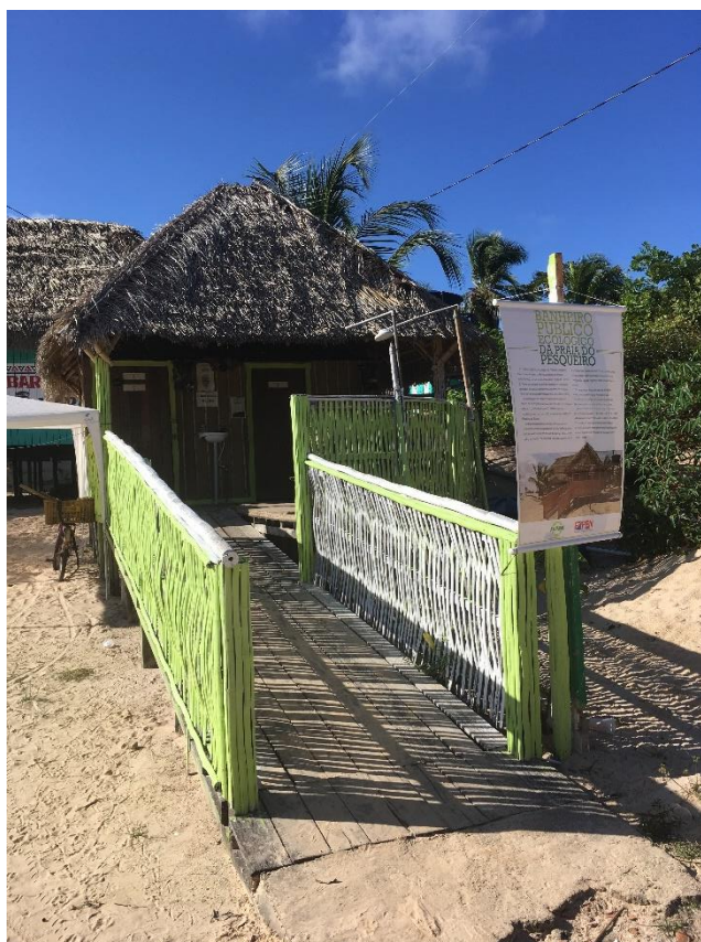
Figura 26 - Banheiro ecológico da praia do Pesqueiro
